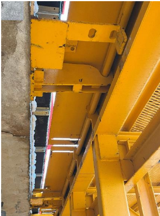
Foto 18 Papegaaienbek aan bovenzijde. Werkt alleen om de steger op zijn plek te houden
