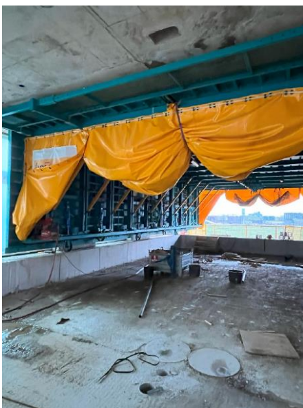
Foto 9 Balkenstructuur voor verdikte lagen, met daarop de tunnelbekisting
