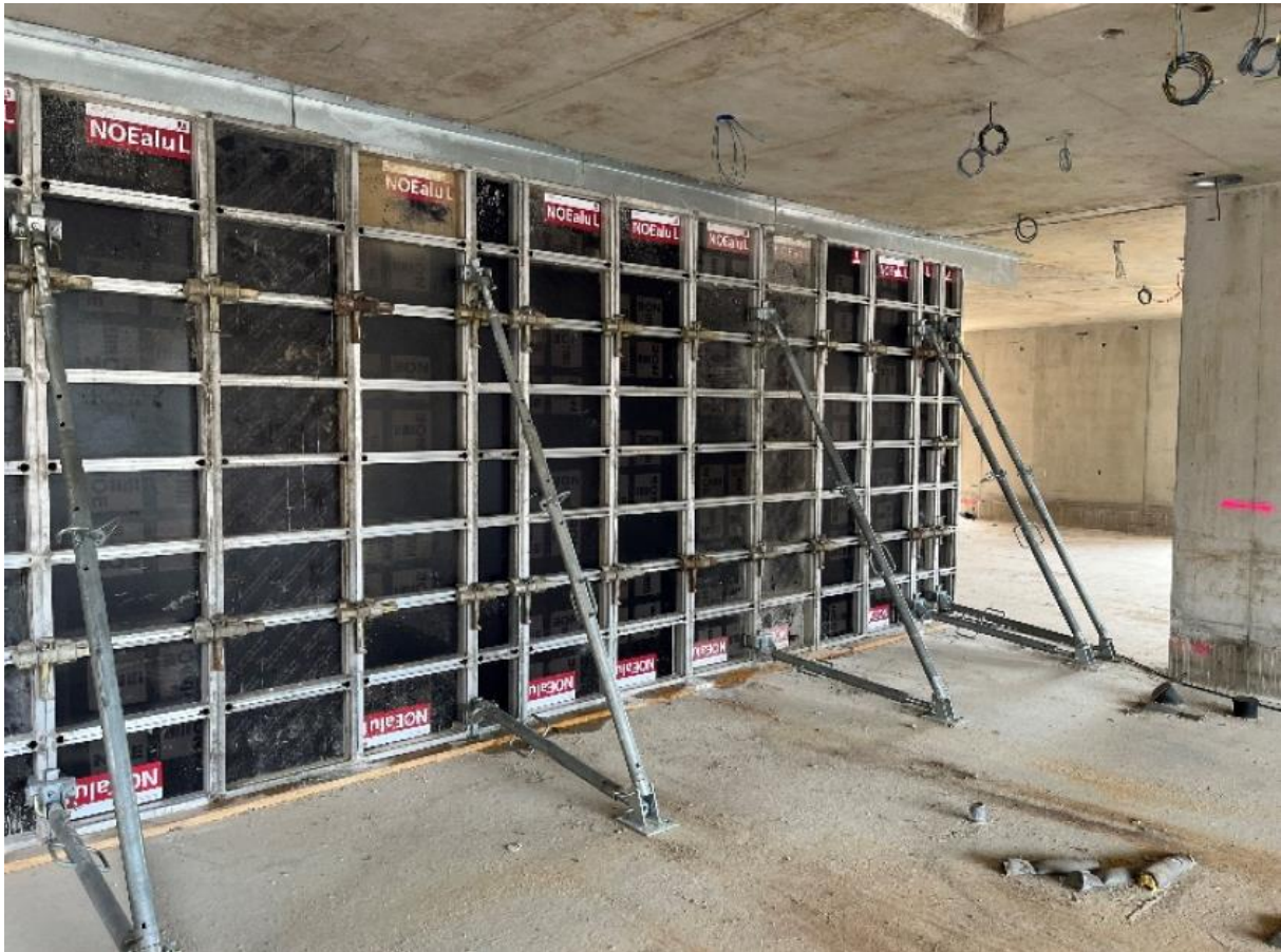
Foto 19 Stabiliteitswanden haaks op de tunnelwanden zijn uitgevoerd met een handzame paneelbekisting
