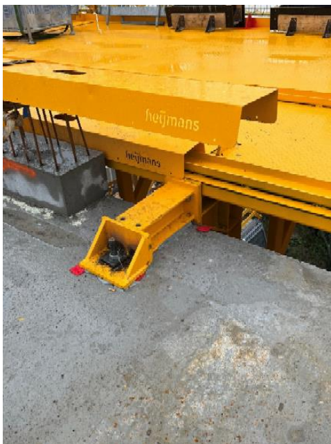
Foto 13 Bevestiging constructief kopgevelsteiger
