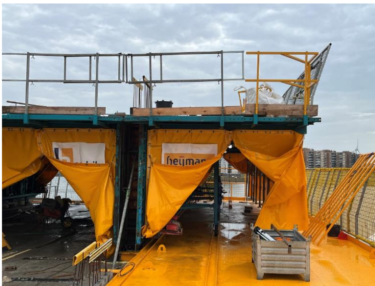
Foto 12 Halftunnel op constructief kopgevelsteiger
