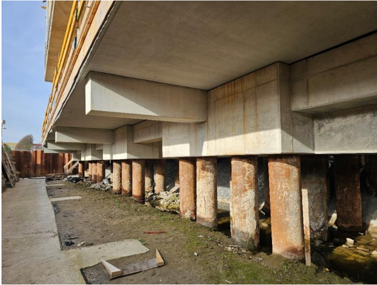
Foto 6 Deels uitkragende fundering voor de balkons van de waterlofts; Tubex-palen onder de waterlofts blijven in het zicht
