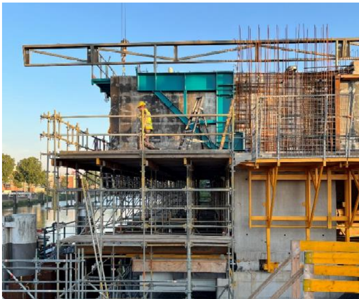
Foto 10 Tijdelijke ondersteuningsconstructie onder tunnelbekisting
