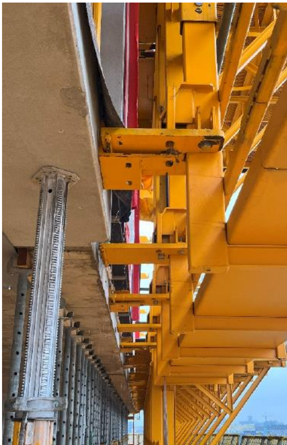
Foto 16 Gevelsteiger aan de onderzijde opgelegd op hoeklijnen
